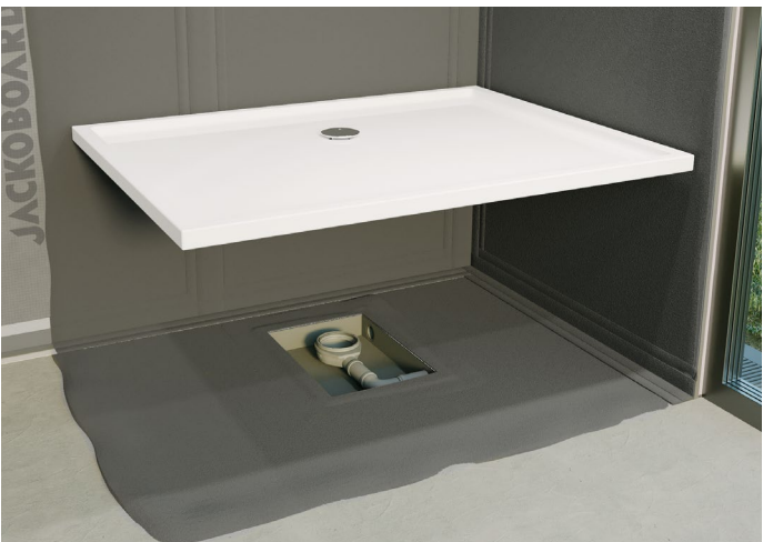
4) Afvoer en douche-element plaatsen
