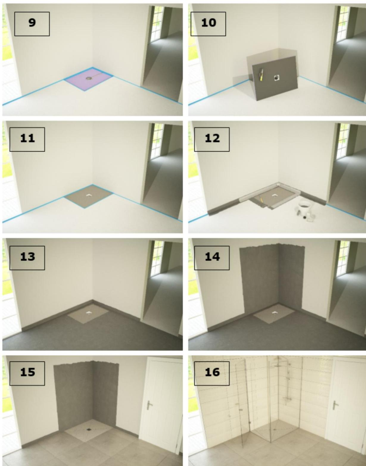
**Figure 13b - Mise en œuvre du procédé avec étanchéité**
