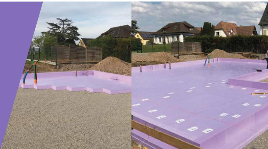
Le système permet de réaliser une jonction sans ponts thermiques
