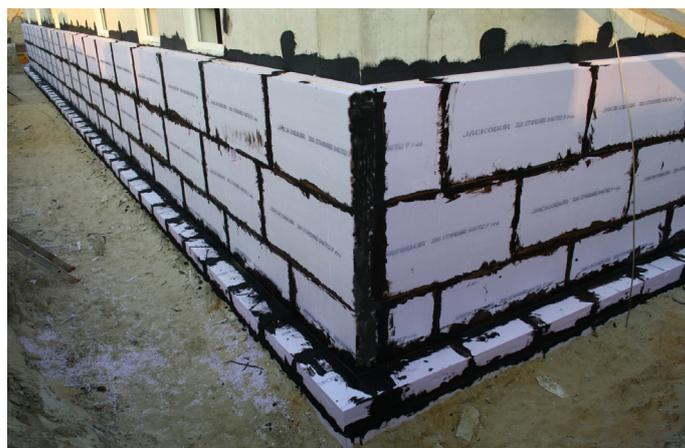
Illustration: pose des panneaux JACKODUR® dans un terrain avec pression d'eau permanente ou longue durée (nappe phréatique).
